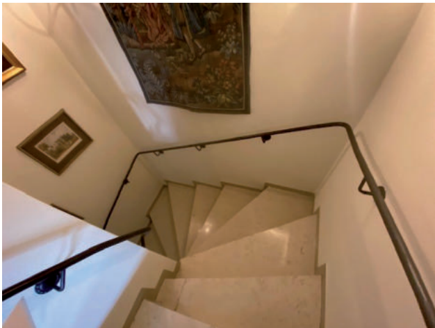
Durchgehender Handlauf Treppe
